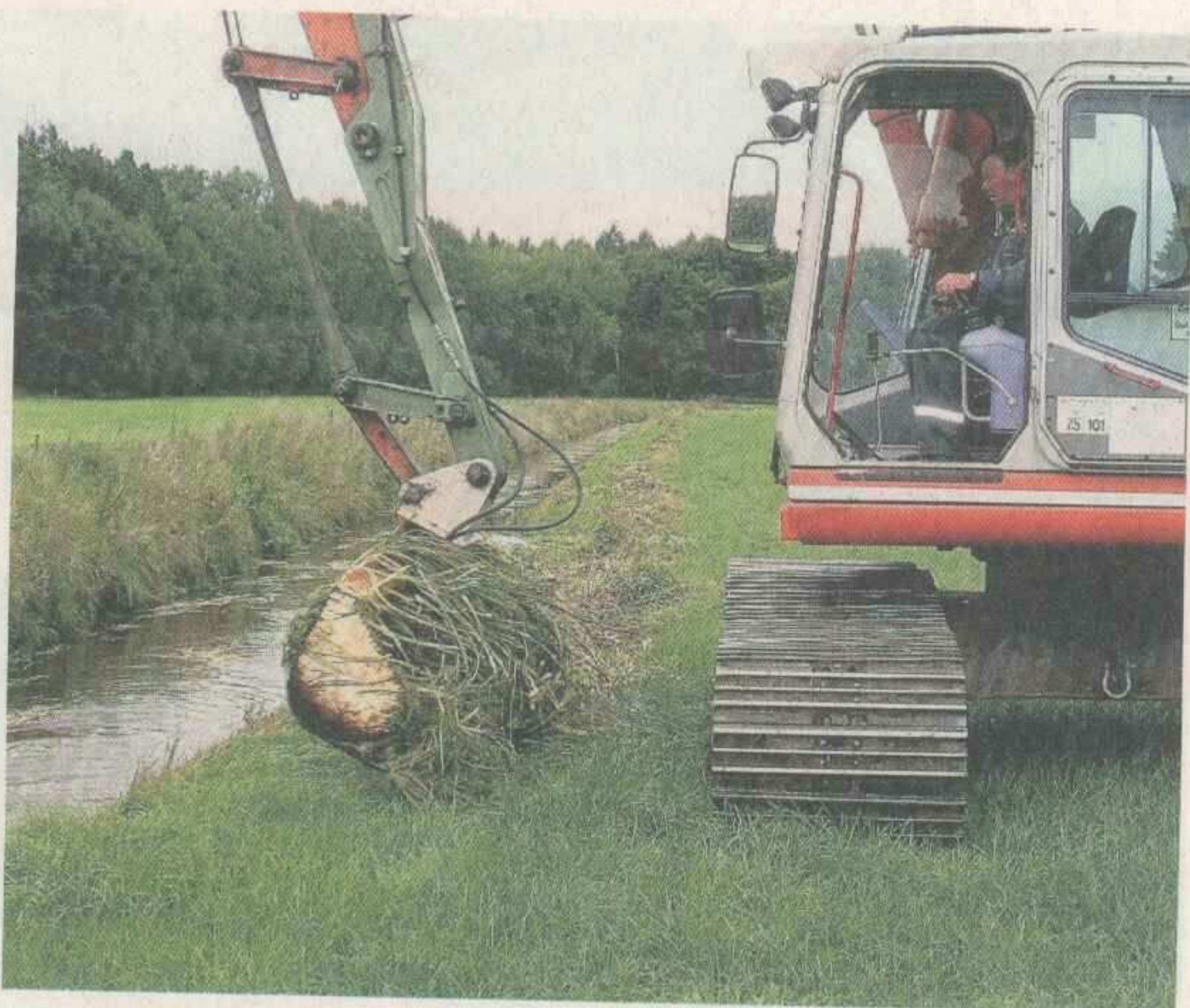
Mit dem Mähkorb am Raupenbagger wird die Twiste naturverträglich geräumt. In diesem Schnittgut befinden sich nicht selten die ungebeteren „Panzerschränke“.
