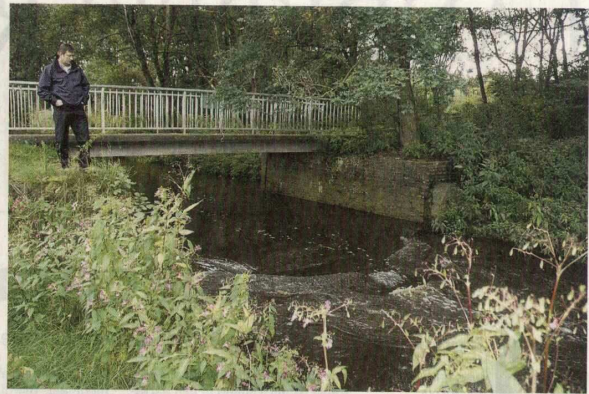
Das Wehr und dieser Kaskadenabsturz beim Golfplatz sollen abgerissen werden. Fotos: jab
