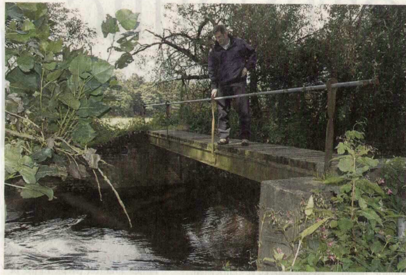
Das Ostestauwehr in der Gemarkung Groß Meckelsen: Ein Hindernis für Fische.
