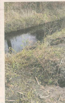
Hier wütet die Erosion.
