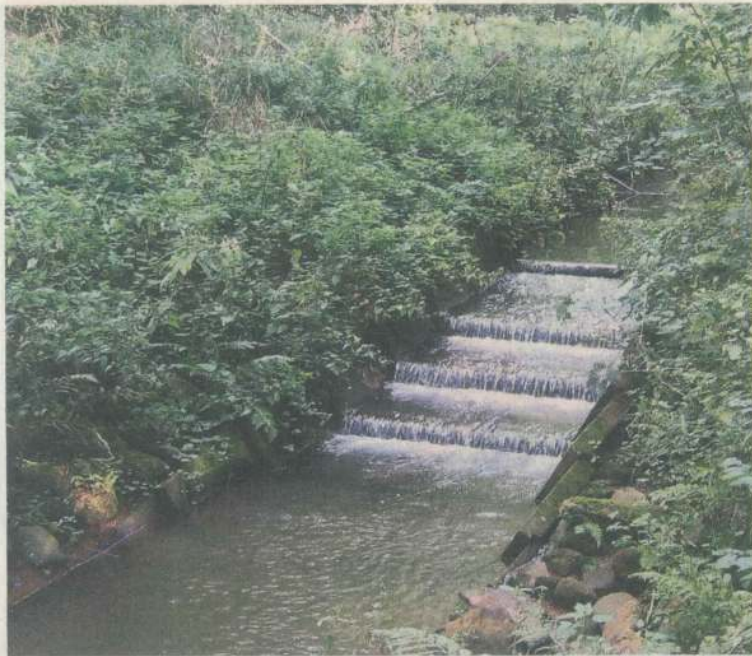
Diesem nun entfernten Kaskadenabsturz kamen Fische nicht hoch.
