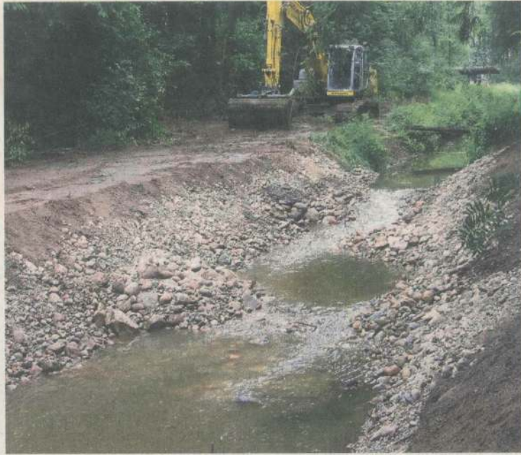
So sieht die frisch angelegte, leicht passierbare Sohlgleite aus.
