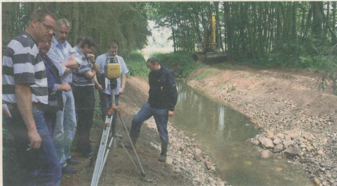
Behördenvertreter inspizieren zusammen mit dem Planer die Baustelle im Alpershausener Mühlenbach. Foto: jab
