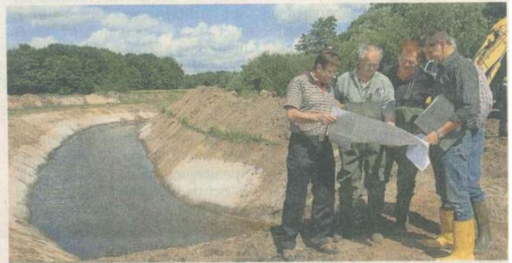
Angler und Behördenvertreter informierten sich gestern auf der Baustelle. Links im Bild ist der Umfluter zu sehen, über den die Oste drei Wochen lang umgeleitet wird.
