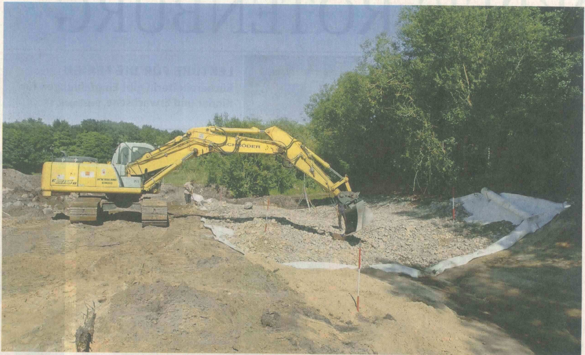
Nach dem Abriss des alten Stauwehres in der Gemarkung Groß Meckelsen erhält die Oste ein neues Bett aus Steinen.
