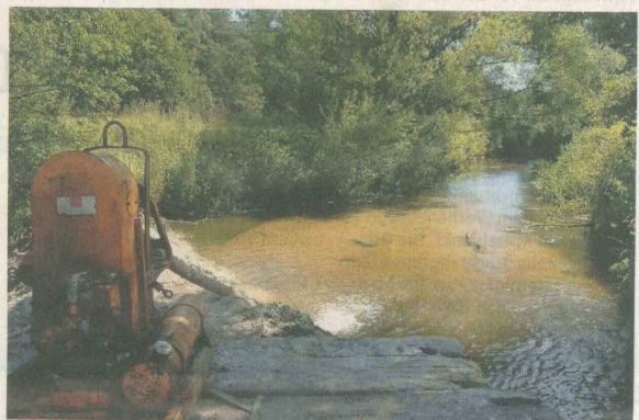
Ohne Pumpe geht nichts: Sie befördert das in die Baustelle nachsickernde Wasser zurück in die Oste.
