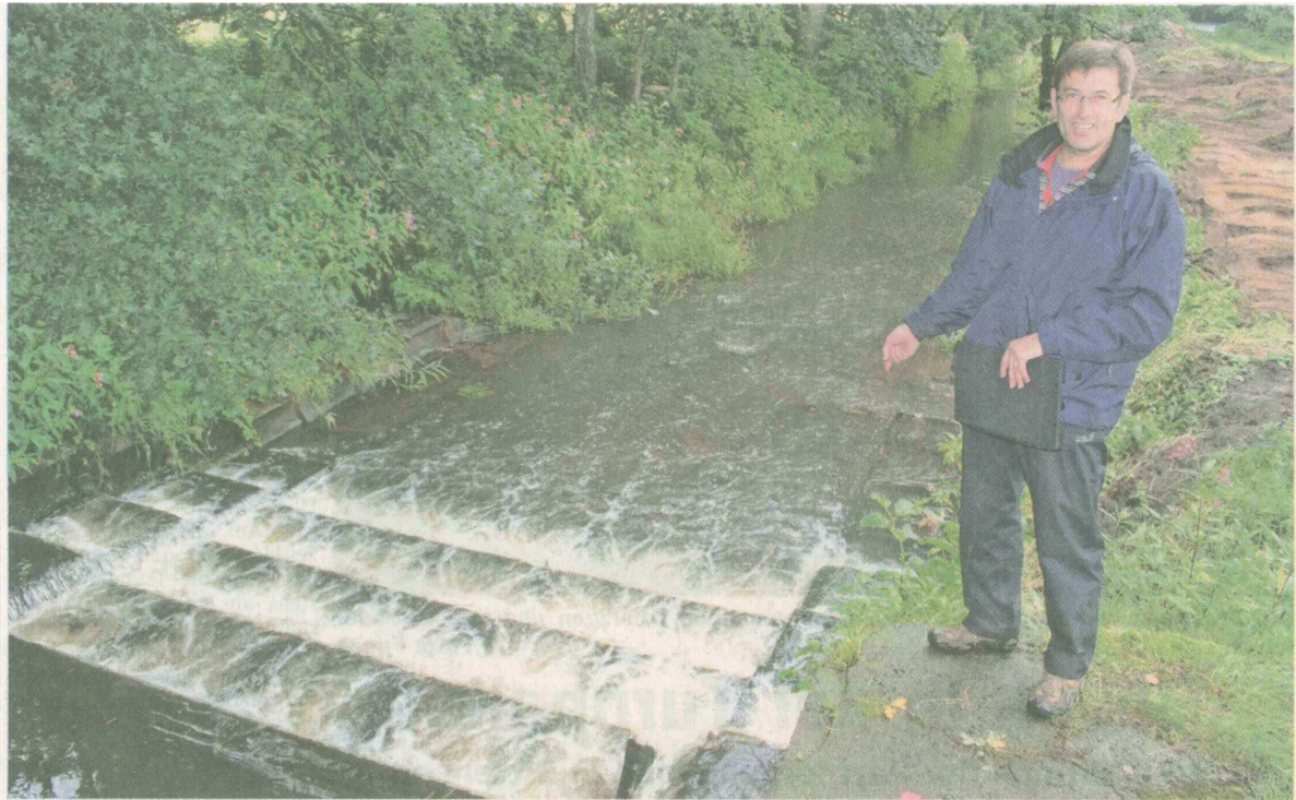
Wilhelm Meyer, Geschäftsführer des Unterhaltungsverbands Obere Oste, zeigt die Kaskade am Golfplatz, die einer Sohlgleite weicht, um die ökologische Durchgängigkeit des Flusses herzustellen Foto: Fricke
