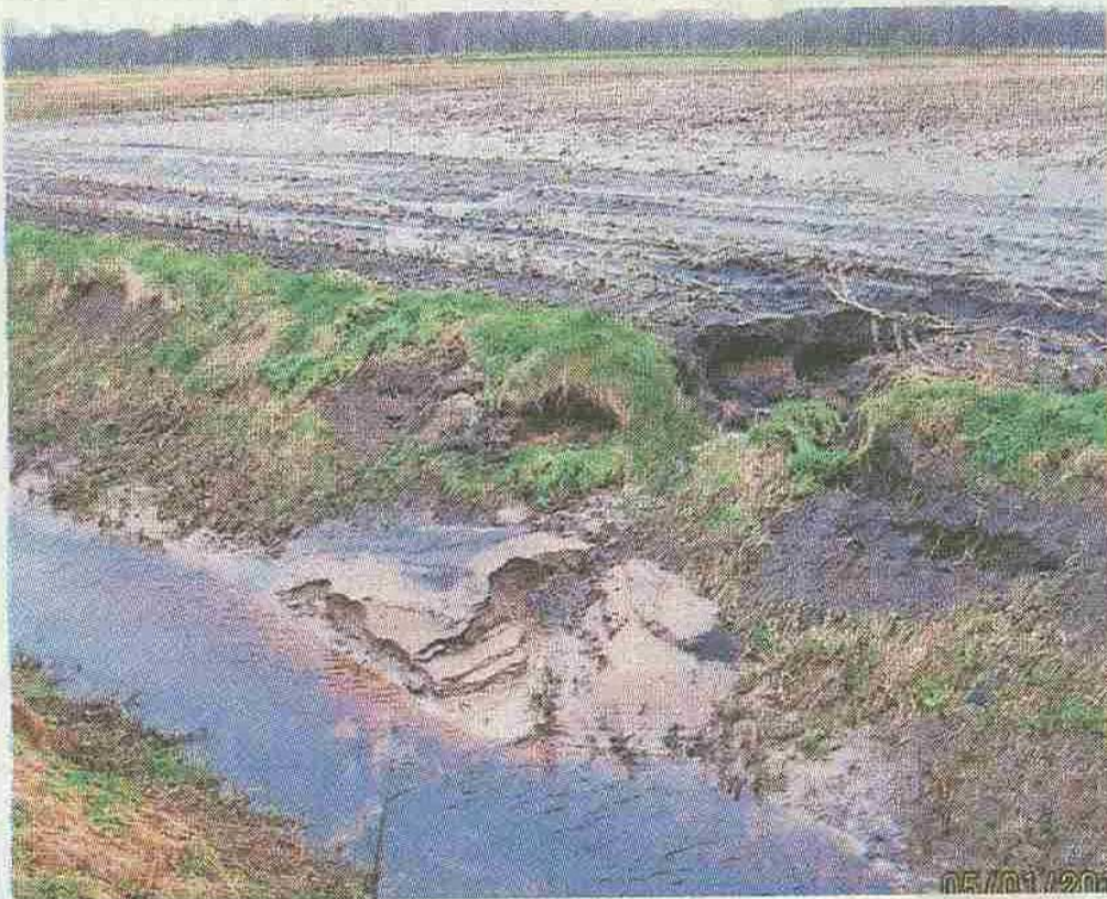
Schäden an der Uferkante behindern den Gewässerlauf in Gräben.
