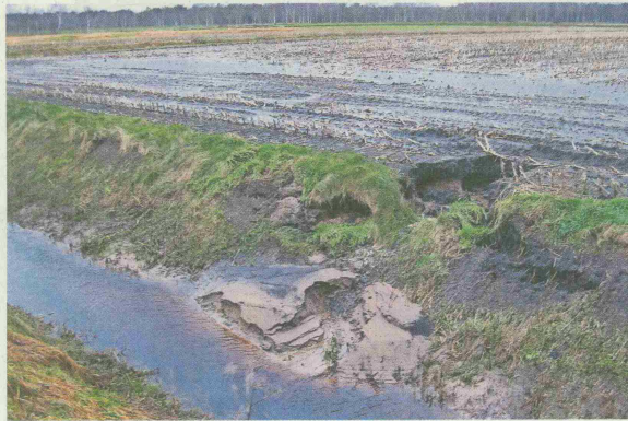
So geht es nicht: Graben vor dem Selsinger Moor-Böschungsauskolkung durch zu nahe Beackerung und Erosionsrinne.
