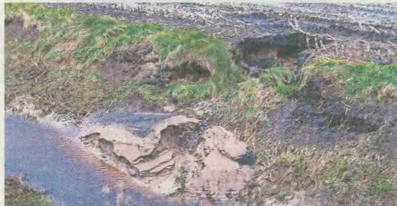
Ein negatives Beispiel: Durch zu nahe Beackerung entstand am Graben vor dem Selsinger Moor eine Böschungsauskolkung.
