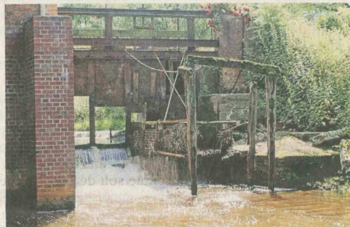
So sah das Mühlenwehr noch im Jahr 2013 vor Beginn der Bauarbeiten aus.
