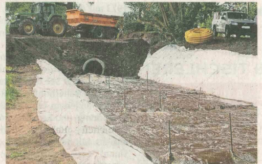
Die Bever wird momentan umgeleitet , damit die Umbaumaßnahmen durchgeführt werden können.
