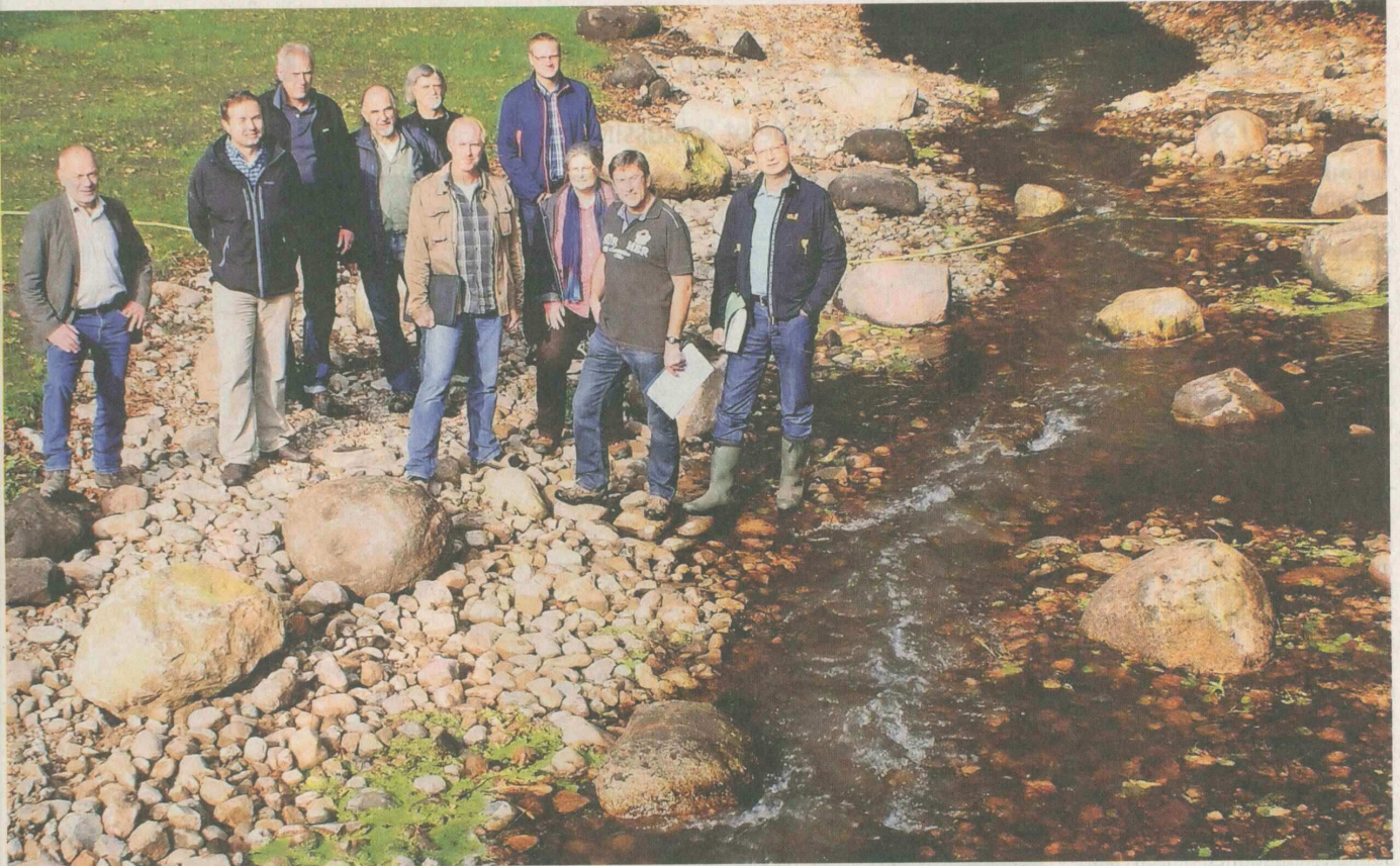
Fische können die Bever ab sofort ein gutes Stück weiter hinaufschwimmen: Am Mittwoch erfolgte die offizielle Abnahme der in Malstedt fertiggestellten naturnahen Sohlgleite, die die ökologische Durchlässigkeit des Gewässers erhöhen soll. Fotos: Bick
