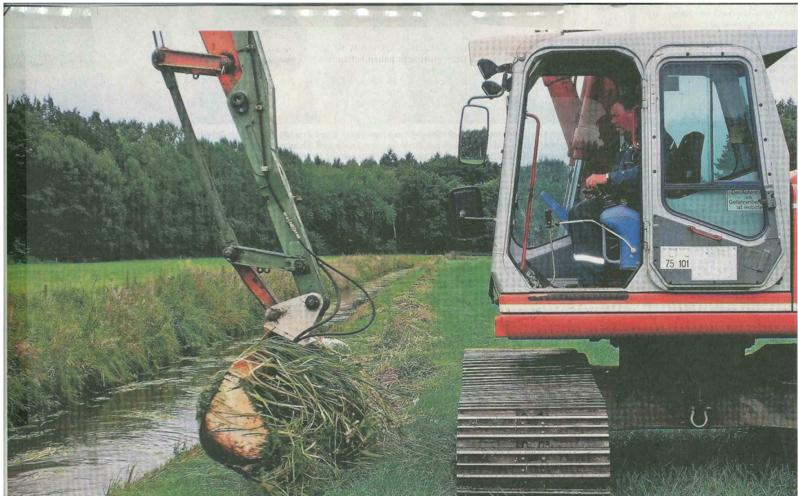
Wenn sich der Sommer allmählich dem Ende zuneigt, ist die Zeit gekommen, in der zu üppiger Grünbewuchs aus Flüssen und Bächen entfernt werden muss, um bei starken Niederschlägen mögliche Überschwemmungen zu verhindern. Hier ist der Lohnunternehmer Wilfried Meier aus Hohenhausen an der Twiste in der Gemarkung Brauel tätig. Fotos Millert
