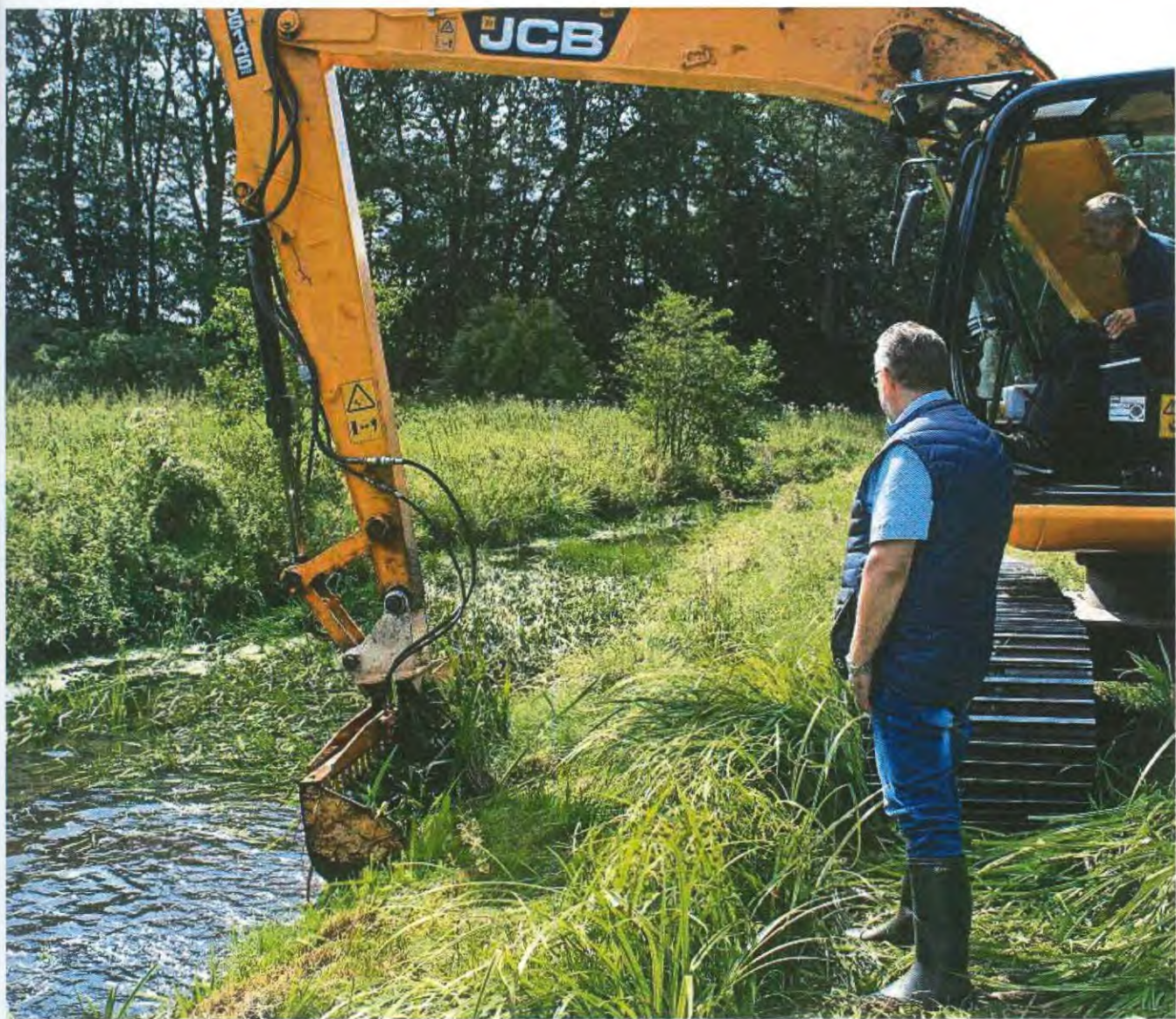
Während der Bagger das untere Bachstück bereits geräumt hat, ist rechts das ganze Ausmaß der total verkrauteten Mehde zu erkennen. Dirk Glaß (vorne) ist zufrieden, mit welcher umweltschonenden Systematik Baggerfahrer Detlef Berg bei den Räumarbeiten zu Werke geht. Fotos: Millert
