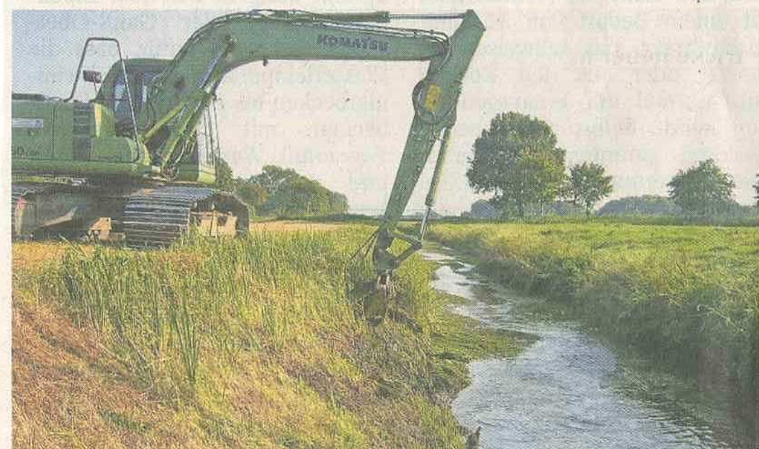
Mähkorbbagger im Einsatz an Aue und Mehde.
