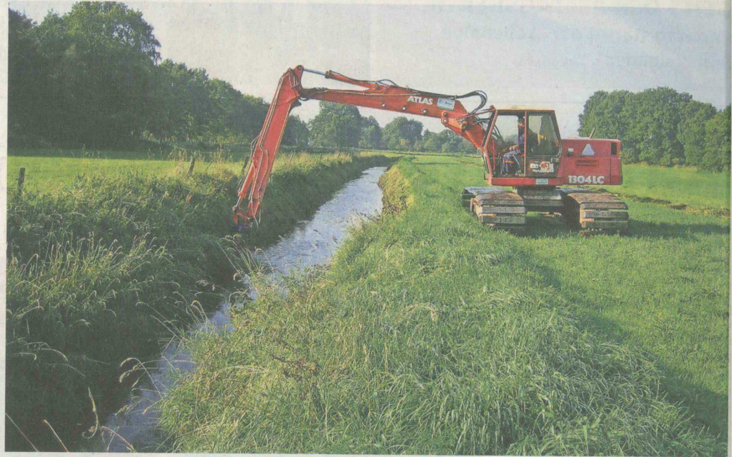
Im Namen des Unterhaltungsverbandes sind im vergangenen Jahr 501 Kilometer Wasserläufe geräumt worden – zumeist mit dem Mähkorbbagger (Foto) – wenige Abschnitte auch von Handräumern.
